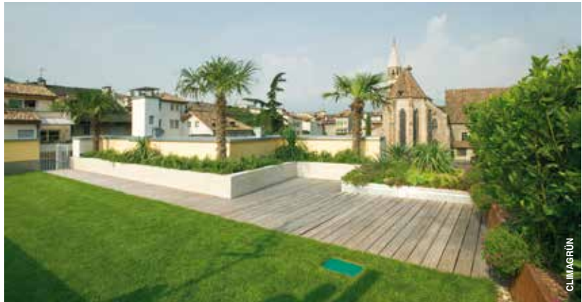
Verde pensile, strumento di riqualificazione delle aree residenziali. Green roofs, a tool for upgrading residential areas.
